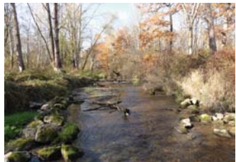
▲ Bsp. 1: Naturnah heißt Platz für die Eigendynamik: Der Uferverbau wird entfernt, die Steine werden zum Teil im Gewässer belassen. Auch das Totholz schafft Struktur für das Gewässer und fördert dynamische Prozesse.
