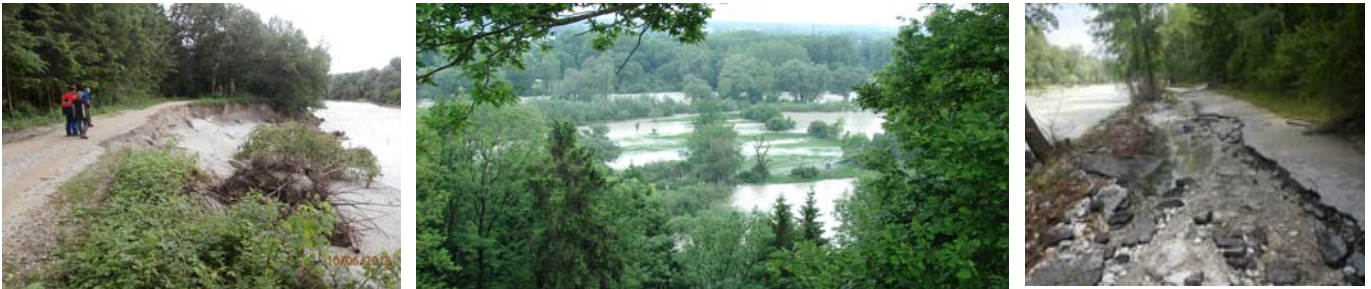
Impressionen vom Hochwasser 2013: Hangenham, Isarweg in Unterföhring und Uferanbruch in Achering
