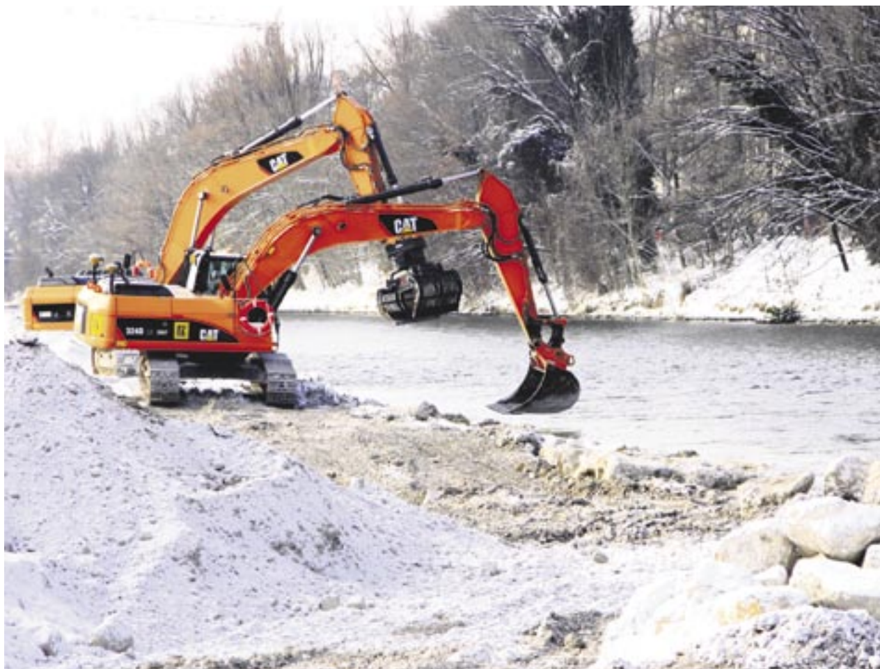
Die Baustelle zieht sich zwischen dem Flusskilometer 148+350 und 148+850 hin.
