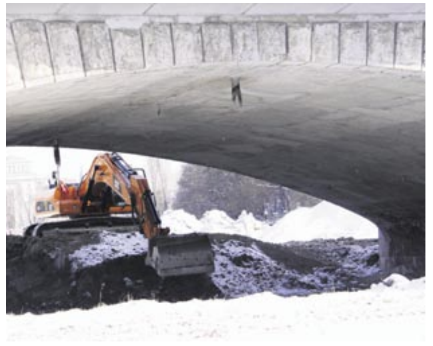
Ab Januar 2011 werden sich die Bauarbeiten rund um die Reichenbachbrücke und den neuen Seitenarm der Isar konzentrieren. Bisher läuft die Isar durch den ersten Brückenbogen. Dies soll sich ändern. Die Baufirma hat zur Aufgabe, die Pfeilerinsel zwischen Kleiner und Großer Isar zu verlegen – sie wird nun südlich der Reichenbachbrücke errichtet.
