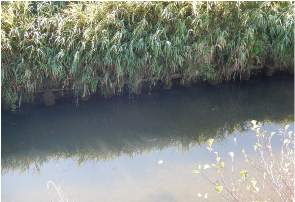
Abb. 1: Uferbefestigung bei Fkm 109,8
