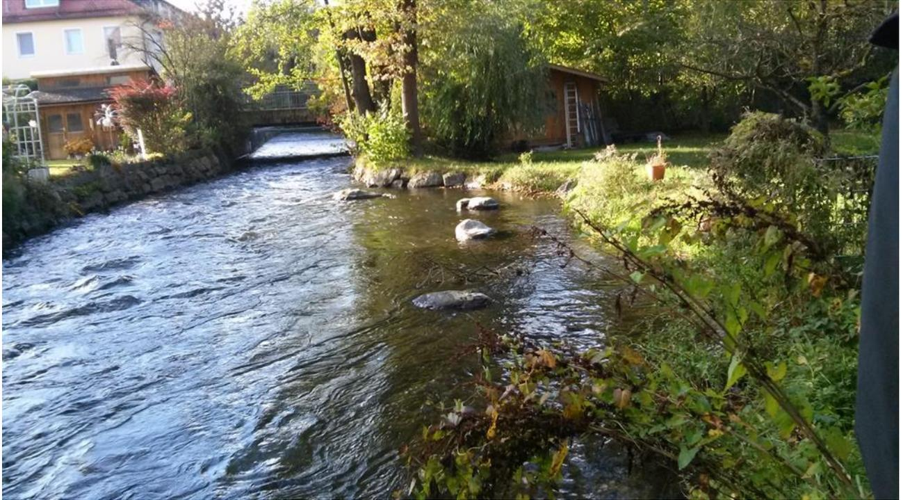
Abb. 4: Ist-Situation Würm bei Fkm 12,25 – Uferaufweitung, Störsteine und beruhigter Strömungsbereich zur Habitatverbesserung im Gewässer
