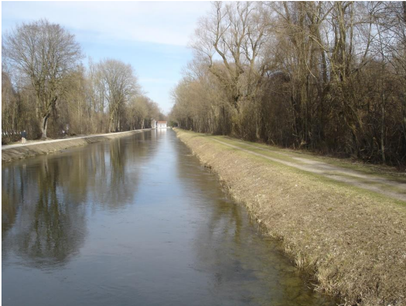
Abb. 15: Amperkanal und Kraftwerk (Foto: R. Engemann, 22.03.2019)
