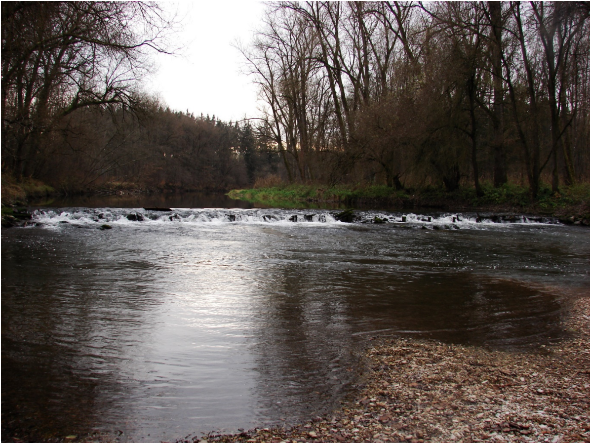
Ein Wanderhindernis – der Absturz in der Amper bei Inkofen, der nun umgebaut wird (Foto: WWA München)
