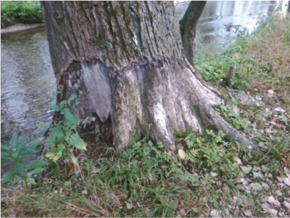
Stammfuß einer Pappel am Ufer des Würmkanals vom Biber geschädigt.
