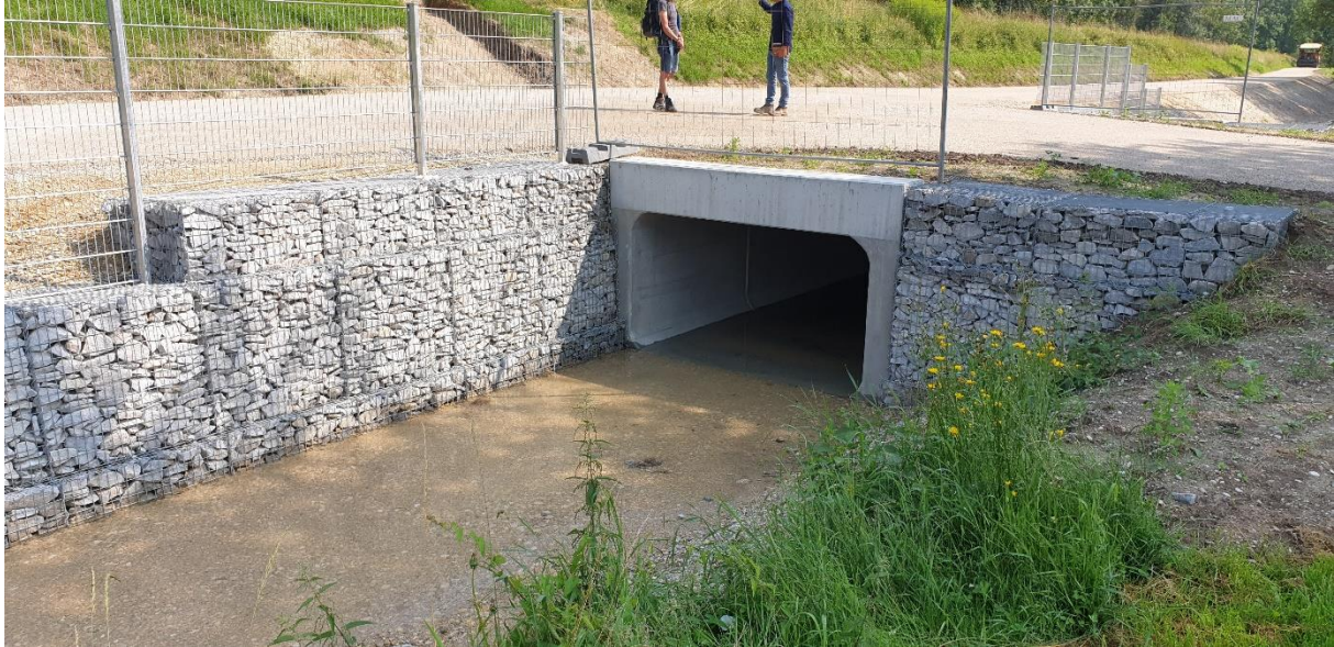
Abbildung 2: Neuer Stahlbetondurchlass an der Unteren Isarau (Bild: WWA München)
