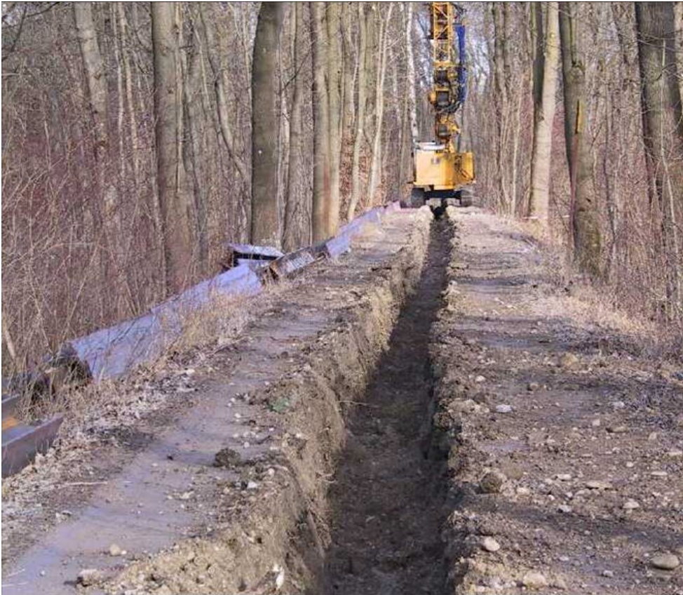
Herstellung der Bohrpfehlwand
