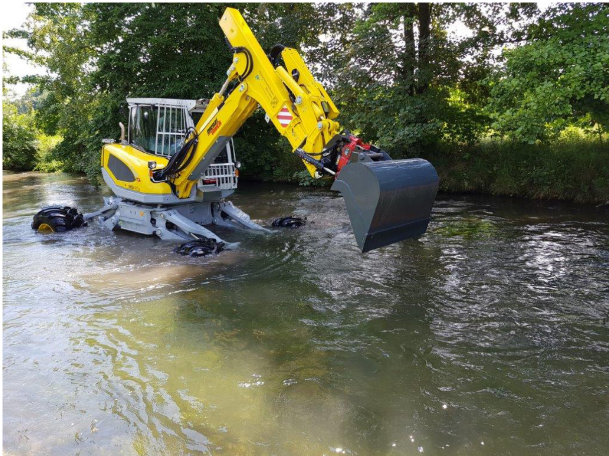
Schreitbagger der Flussmeisterstelle Freising im Einsatz
