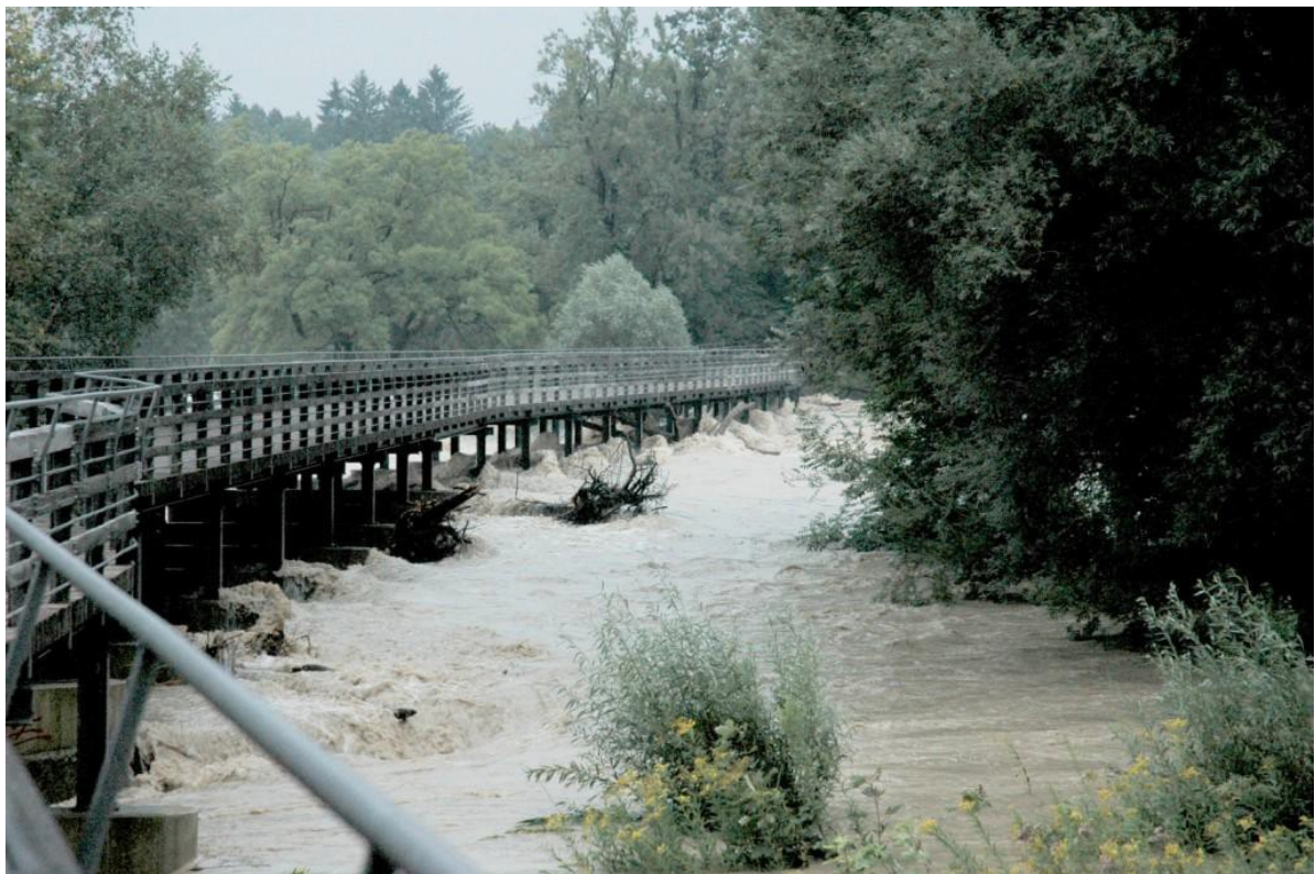
Hochwasser 2005 am Flauchersteg
