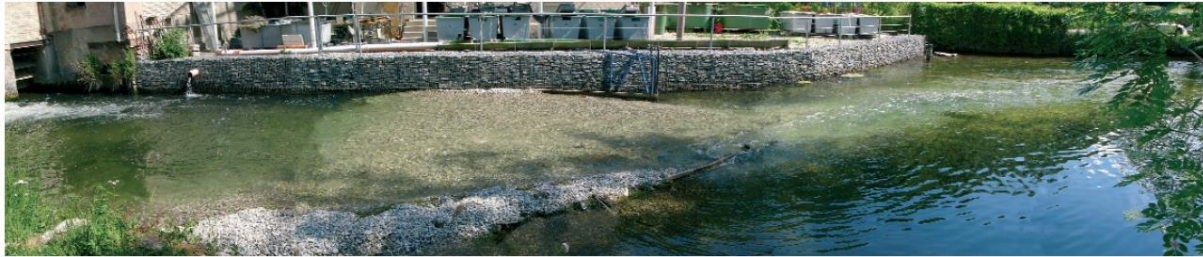
Abbildung 4: Fertig restaurierter Laichplatz an der Moosach. Hier kamen der Bau einer Buhne und eine Kieszugabe zum Einsatz. (aus Pulg, 2007)
