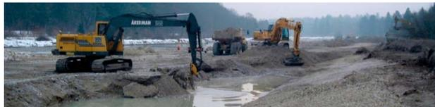
Verdeckte Ufersicherung: Vorgefertigtes Ufer mit angeschütteter Kiesbank
