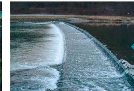
Die regelmäßige Abfolge von Sohlstufen, alle 200m eingebaut, damit sich der begradigte Fluss nicht in den Untergrund einräbt, behindert die Laichzüge der Fische und verwandelt die Isar bei Niedrig- und Mittelwasser in eine Kette aufgestauter Weiher.
