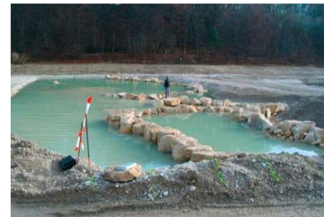
Sohlrampe im Bau: Gut erkennbar ist die Struktur aus stufenförmig angeordneten Riegeln und Becken. Gut zu sehen auch der unter den großen Blocksteinen befindliche Unterbau aus 40 bis 60 cm großen Steinen.
