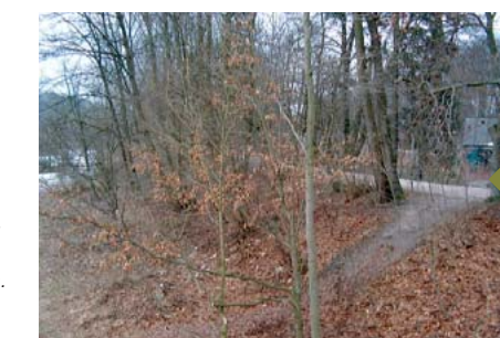
Die alten Deiche waren zu schmal und zu niedrig. Einem Jahrhunderthochwasser mit 1.100 Kubikmeter pro Sekunde hätten sie nicht standgehalten. Zusätzlich war ihre Stabilität durch den Gehölzbewuchs gefährdet.
