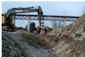
Entwicklungsufer mit rückwärtiger Sicherung (Hier in Form eines trapezförmigen Sicherungsgrabens)
