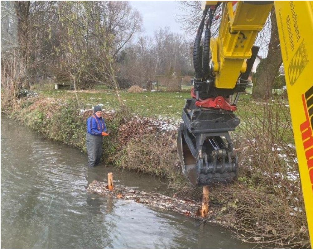
Ein Mitarbeiter der Flussmeisterstelle Freising beim Einbau einer Holzbohle in die Strogen. (Foto: WWA München)
