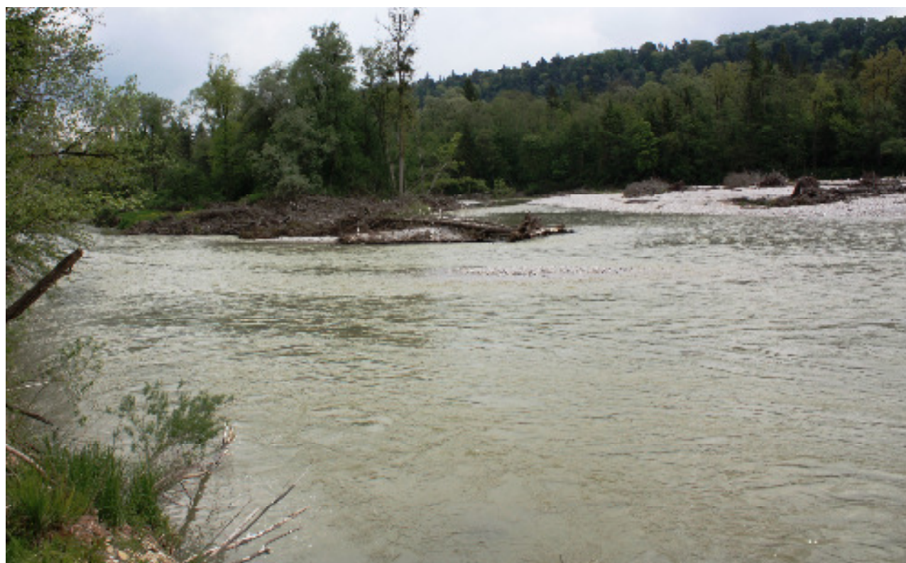
Abb. 2: Ist-Situation 2014 Isar bei Fkm 166: Ein sich verzweigender Flusslauf mit hoher Breiten-, Strömungs- und Tiefenvarianz, Uferabbrüchen und Totholzstrukturen durch bereits erfolgte Renaturierungsmaßnahmen (massiver Uferverbau entfernt).
