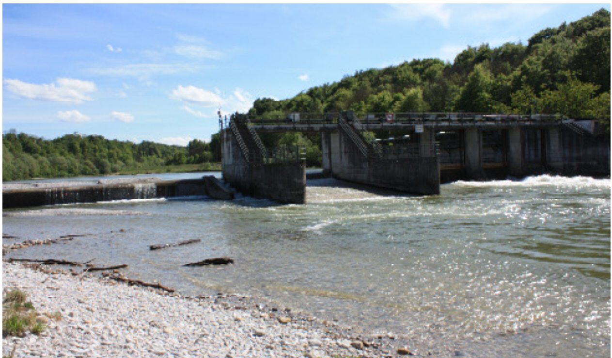
Abb. 1: Großhesseloher Wehr - fehlende biologische Durchgängigkeit
