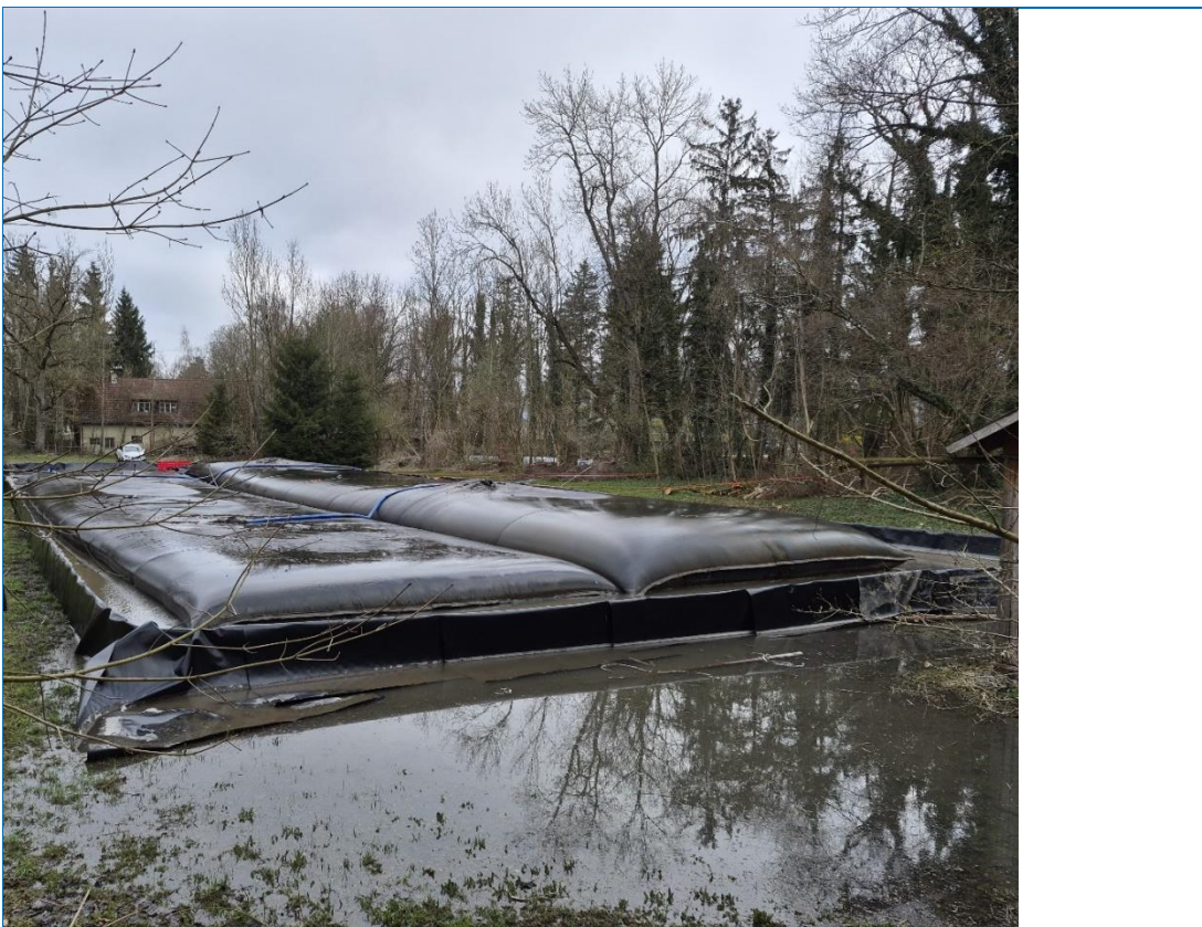
Abb. 2: In den Geotubes trocknet das entnommene Material nun aus.
