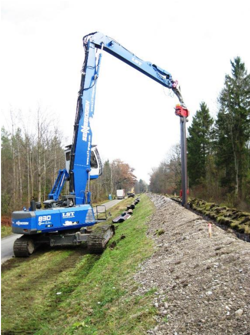
Abb. 2: Einrütteln der Stahlspundwand (Foto: WWA München)
